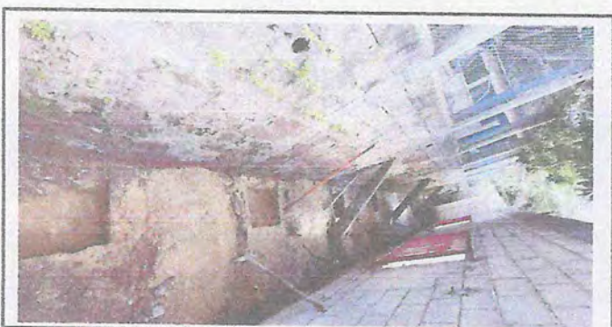
Foto 5: Perforación para colocar columnas de refuerzo.
