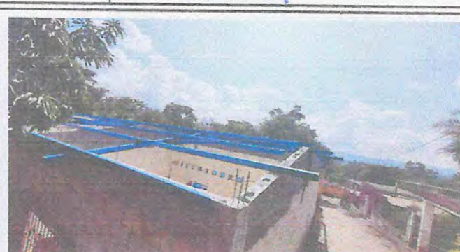
Foto 2: sustitución de estructura metálica Pintada y soldada.
