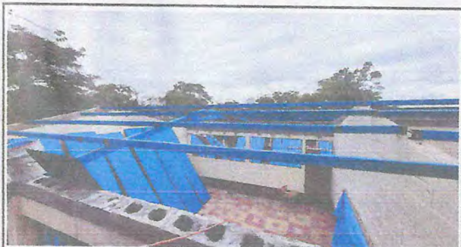
Foto 3: Pintado de Laminas y estructura.
