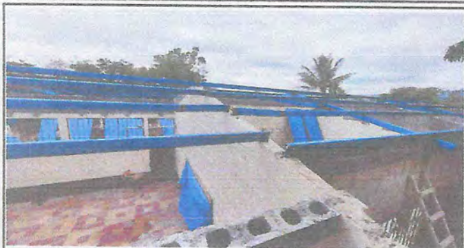
Foto 1: Nivelado de todas las paredes con bolck y fundiciones y corona de hierro.
